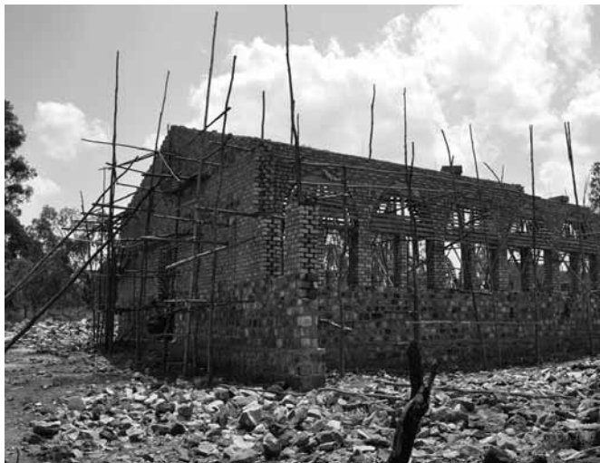
I lavori di costruzione della Chiesa parrocchiale di Kigamba
