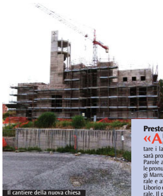
Il cantiere della nuova chiesa
