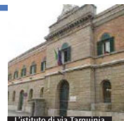
L'Istituto di via Tarquinia
