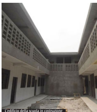
L'edificio della scuola in costruzione
