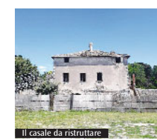
Il casale da ristrutturare
