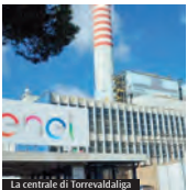
La centrale di Torrevadalis
