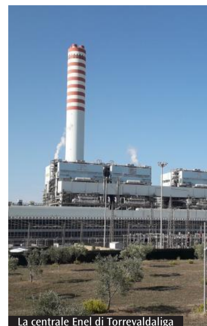
La centrale Enel di Torrevaldaliga
