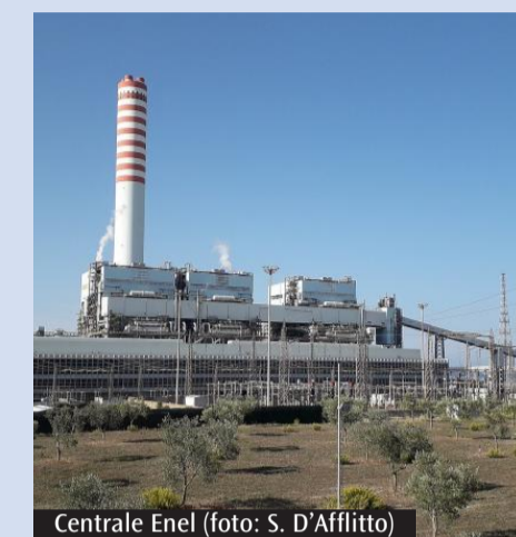
Centrale Enel (foto: S. D'Afflitto)
